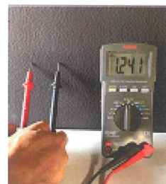
壁に電位が発生している。
